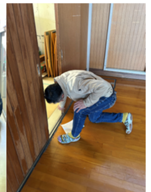
六日市小学校体育館の戸の修理
