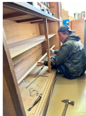
柿木小学校職員室の棚の修理
